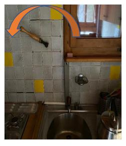
Pour obtenir de l'eau au robinet, ouvrir le robinet et basculer le levier contre la paroi de gauche et de droite.
