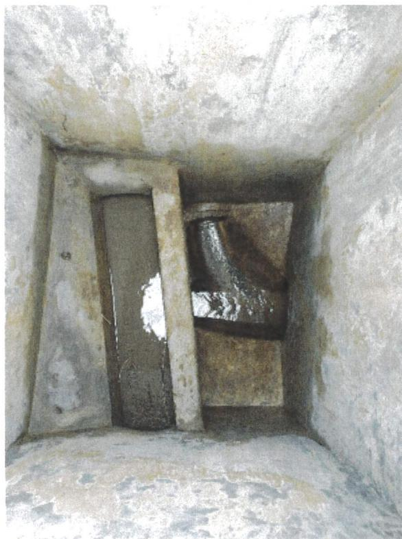
*Figure 1: Situation d'une chambre double existante située sur le tronçon problématique, avec risque de débordement des EC (à gauche) dans les EU (à droite).*
