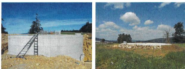
Figure 4 et Figure 5: Exemple de citerne en béton enterrée. La photo de droite montre l'ouvrage remblayé avant la couche de terre sur la dalle
