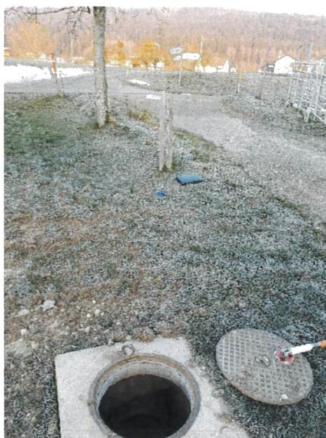
Figure 1 : Situation de la chambre EC privée existante, dans laquelle sera raccordée la décharge et qui sera reprise par la Commune.
